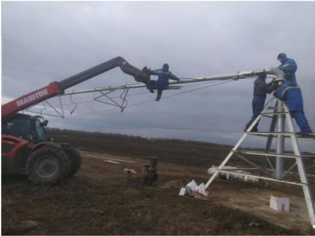
Рис. 16. Отряд «Агроинженер». Бойцы отряда производят сборку и настройку оборудования круговых дождевальных машин
